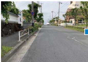
改修工事前(南側より)
