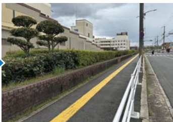
改修工事後(北側より)
