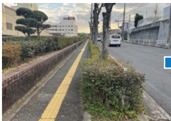
改修工事前(北側より)
