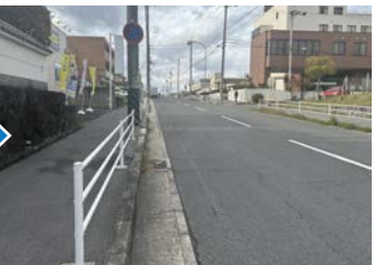
改修工事後(南側より)
